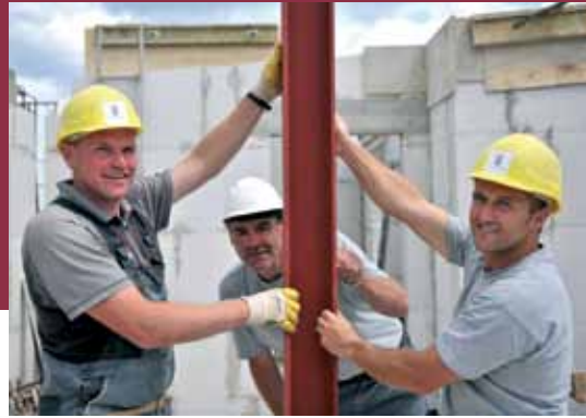
Bildquelle: Bauunternehmung Krieger + Schramm
